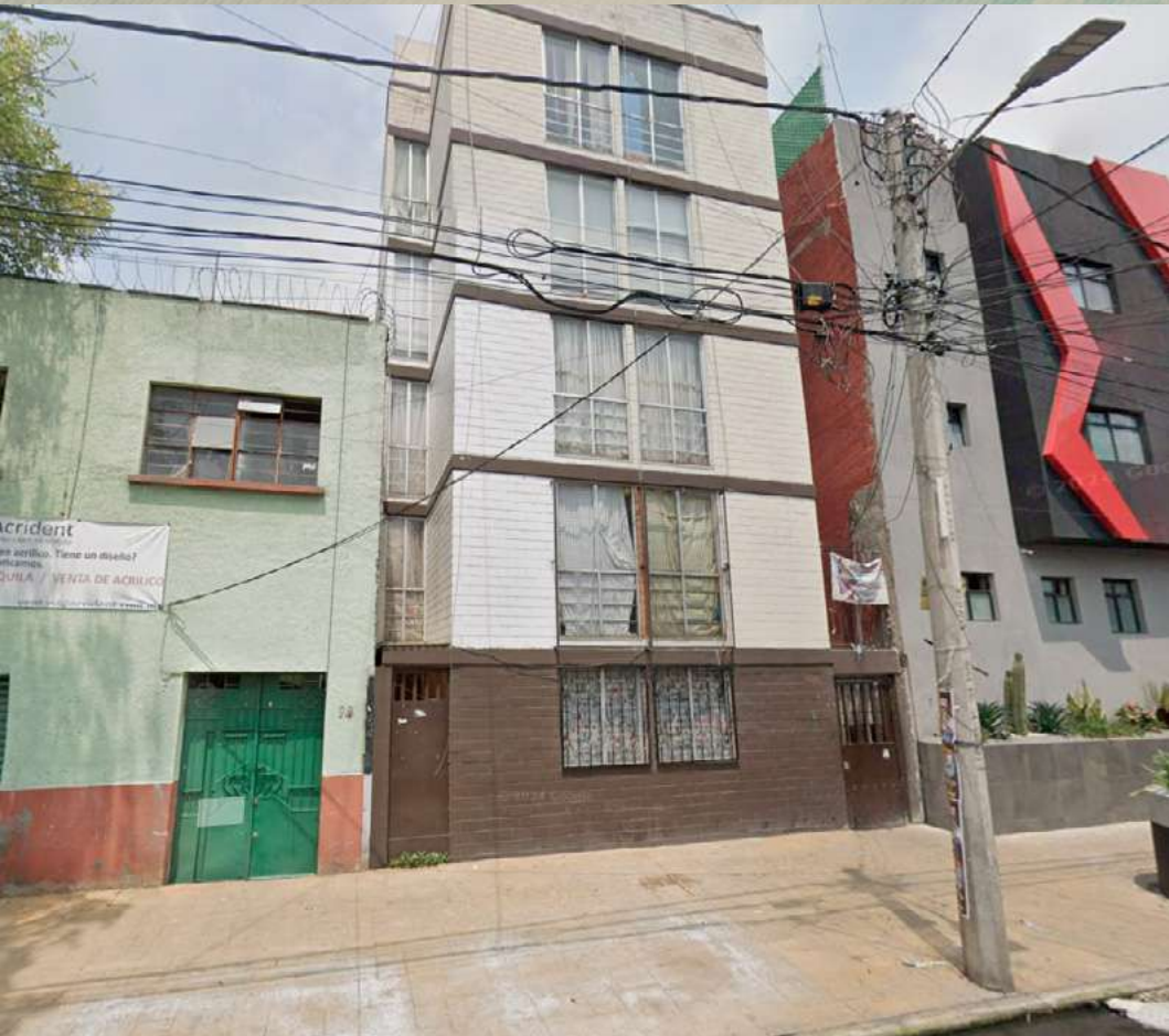
En un departamento de este edificio en Tepito está el domicilio de uno de los supuestos dueños de "Air Cap". HL • FOTOS: AGENCIA
